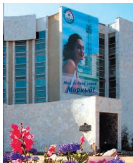
Центральная больница г. Мирного
